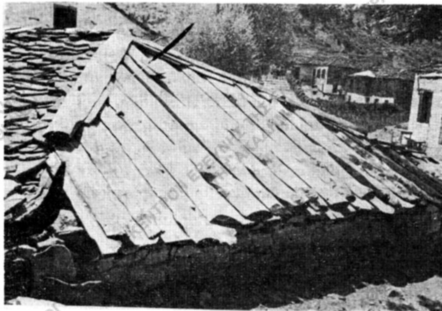
Εἰκ. 1. Στέγη ἐκ πλακῶν καὶ κορμῶν δένδρου.
