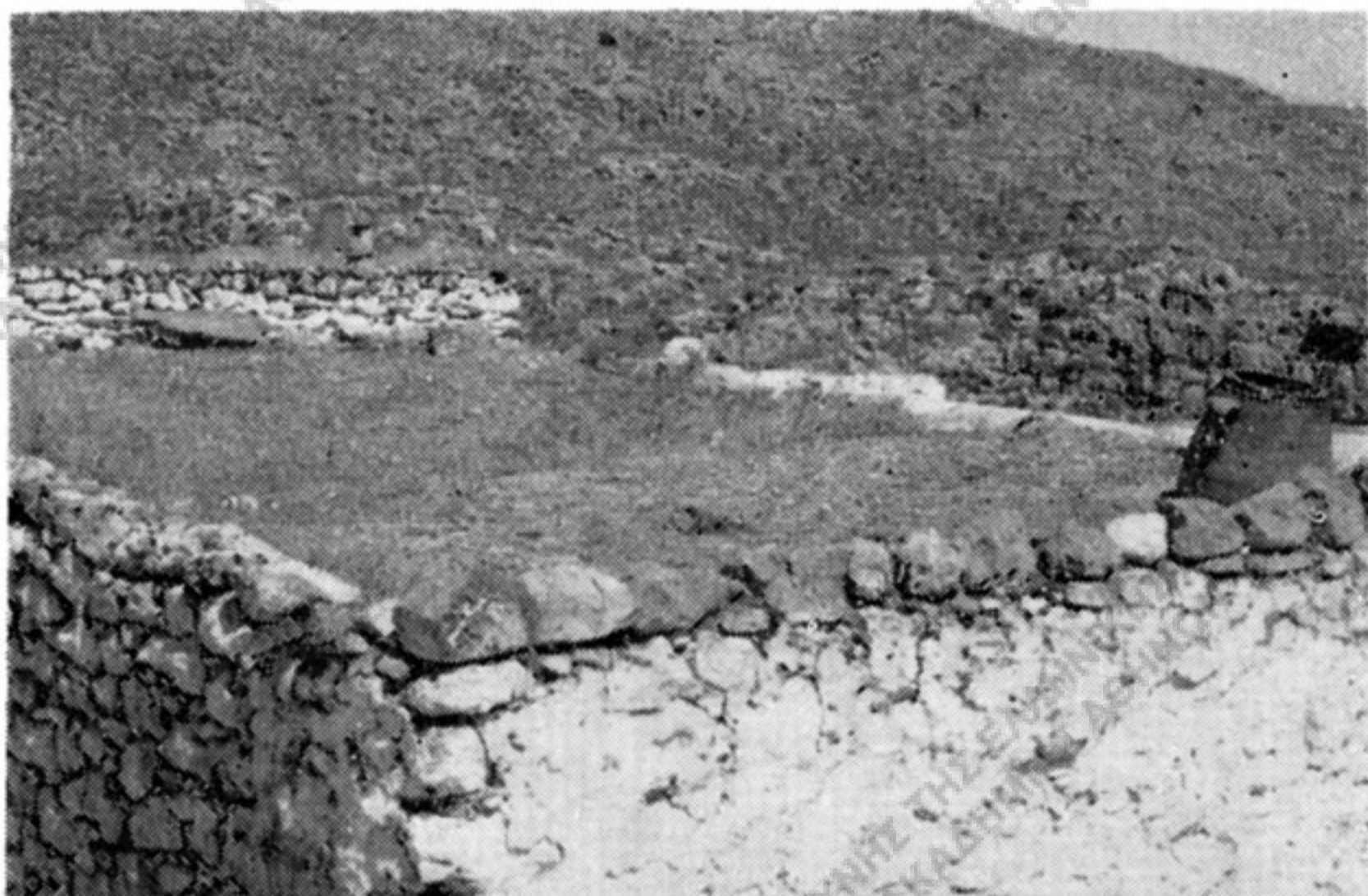
Εἰκ. 2. Δῶμα. Διακρίνονται οἱ ἀκροδοῦχοι καὶ ὁ ἀνηφορᾶς (καπνοδόχος).
