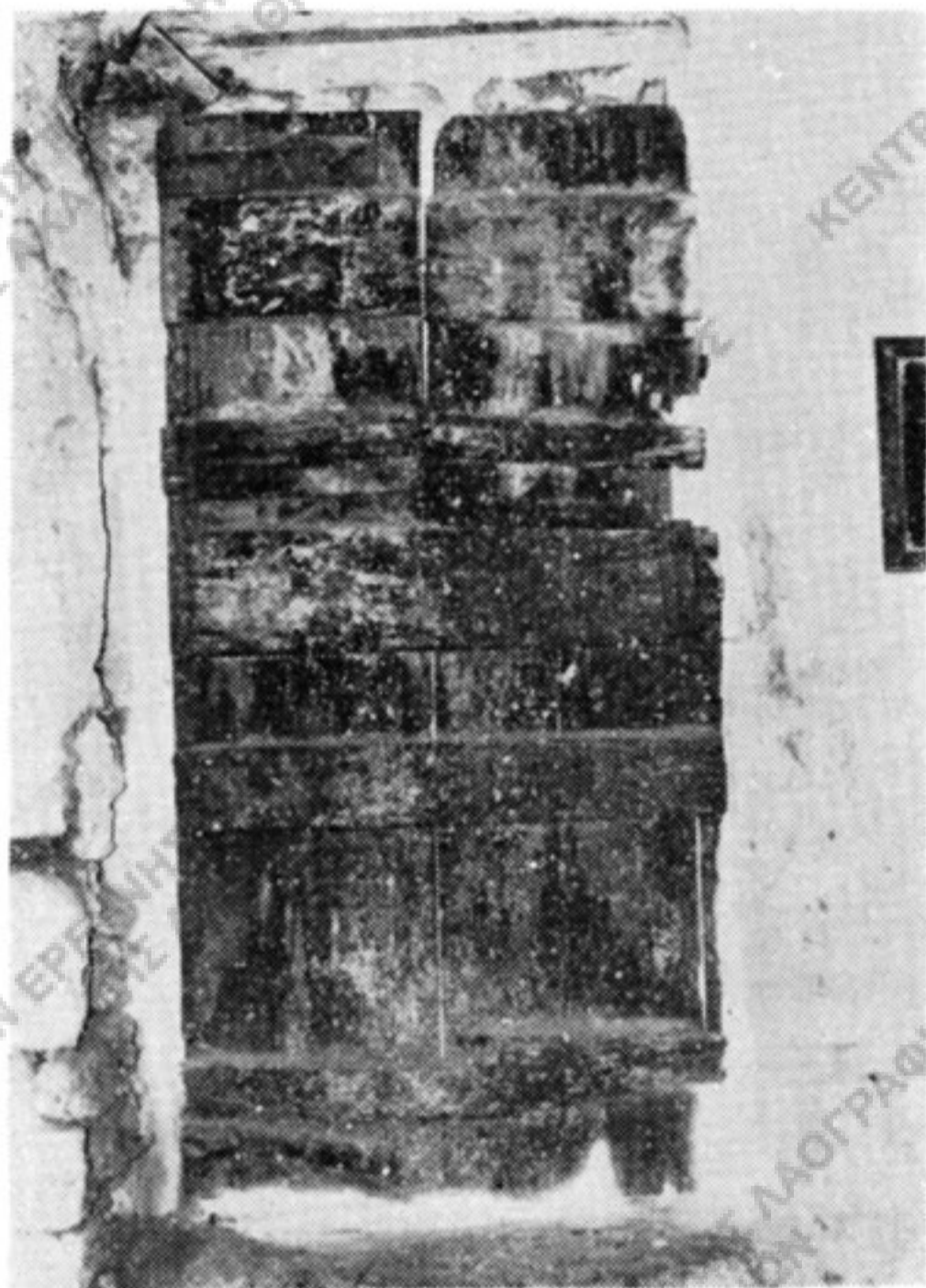
Εἰκ. 7. Πόρτα. Διακρίνεται, ἄνω δεξιά, τὸ πανωπόρτι.
