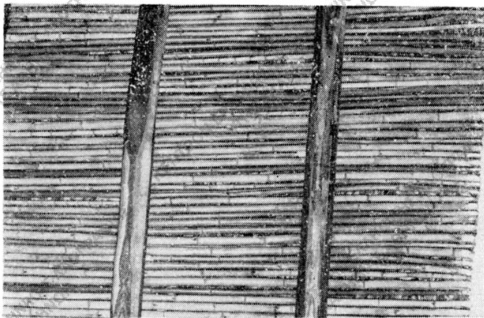
Εἰκ. 3. Στέγασις μὲ καλάμια.
