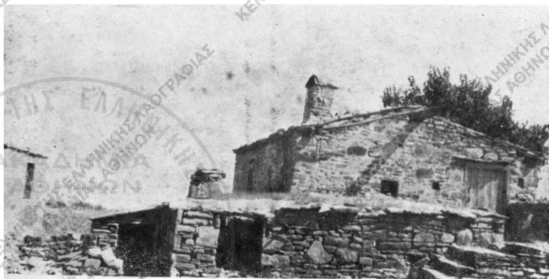
2. Παλιό μονόσπιτο με τὴν άξάταν ὑψουμένην ἀνωτέρω τοῦ δαπέδου τοῦ ἀνωγείου καὶ προεκτεινομένη πλάγιως ἐν Φυσίῃ. Βλέπε τὴν μεσοδόκην τῆς στέγης προεκβαλλομένην ἔξω τοῦ προσθίου τοίχου.
