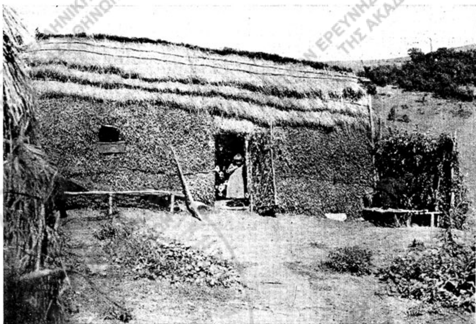
2 Τετράπλευρος καλύβα Κ. Ζαχαρή (Πισοδέρι).
