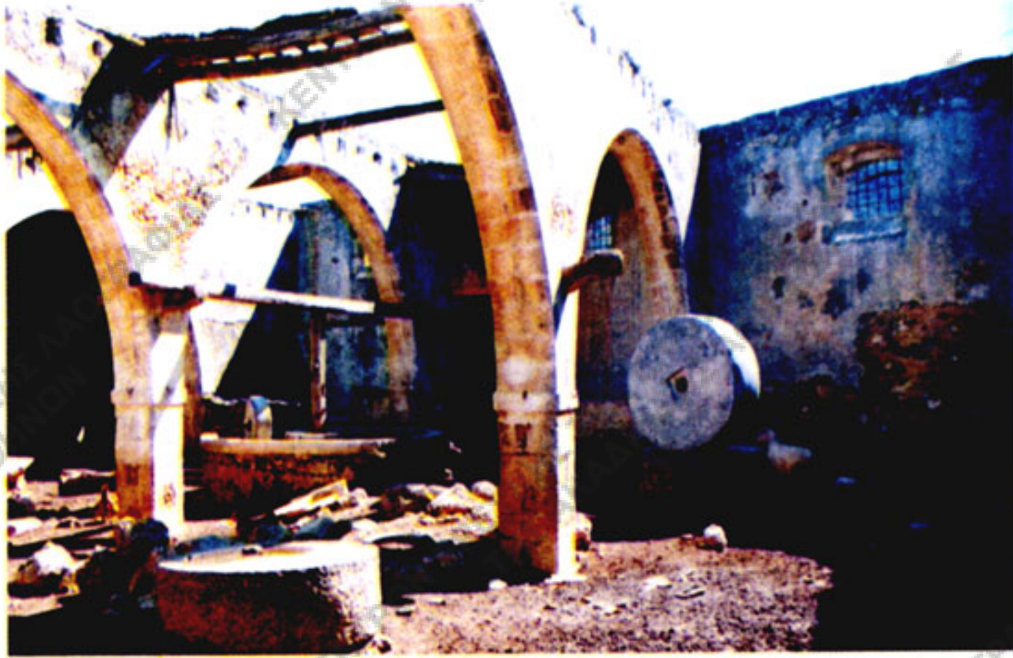
Εικ. 3. Ερείπια μεγάλου ελαιοτριβείου της βενετοκρατίας με πολλές καμάρες στον πύργο του χωριού Μαρουλάς Ρεθύμνου. Διακρίνονται η βάση του μύλου, η κατώπετρα, πάνω στην οποία γυρίζουν τα μολάρια (μυλόπετρες), το κάθετο ξύλο, γύρω από το οποίο περιστρέφονταν οι μυλόπετρες, διάφορες μυλόπετρες κ.ά. (Φωτ. Χρυσούλας Ζήκου, την οποία ευχαριστώ και από εδώ, Χανιά 2000).
