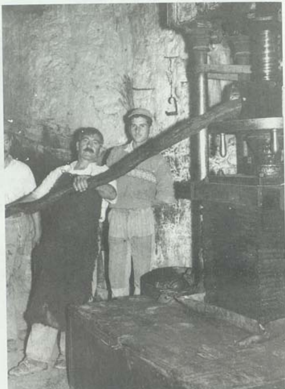
Εικ. 6. Οι εργάτες ελαιοτριβείου (αλιτριβιδιάρηδες) στο Λασιθι γυρίζουν με δύναμη τον μοχλό, που κατεβάζει το πάνω μέρος της φάμπρικας, για να συμπιεστούν οι ελιές. (Φωτ. Κώστα Παπασηφάκη, Νεάπολη Λασιθίου, από το φωτογραφικό αρχείο του Σ.Ε.Δ.Η.Κ., Χανιά).
