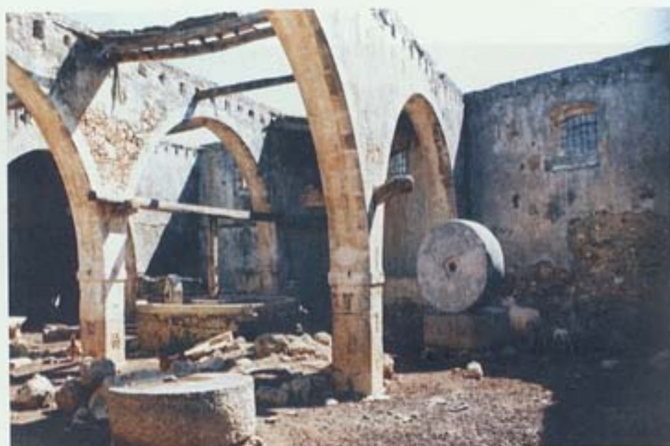
Εικ. 3. Ερείπια μεγάλου ελαιοτριβείου της βενετοκρατίας με πολλές καμάρες στον πύργο του χωριού Μαρουλάς Ρεθύμνου. Διακρίνονται η βάση του μύλου, η κατώπετρα, πάνω στην οποία γυρίζουν τα μολάρια (μυλόπετρες), το κάθετο ξύλο, γύρω από το οποίο περιστρέφονταν οι μυλόπετρες, διάφορες μυλόπετρες κ.ά. (Φωτ. Χρυσούλας Ζήκου, την οποία ευχαριστώ και από εδώ, Χανιά 2000).
