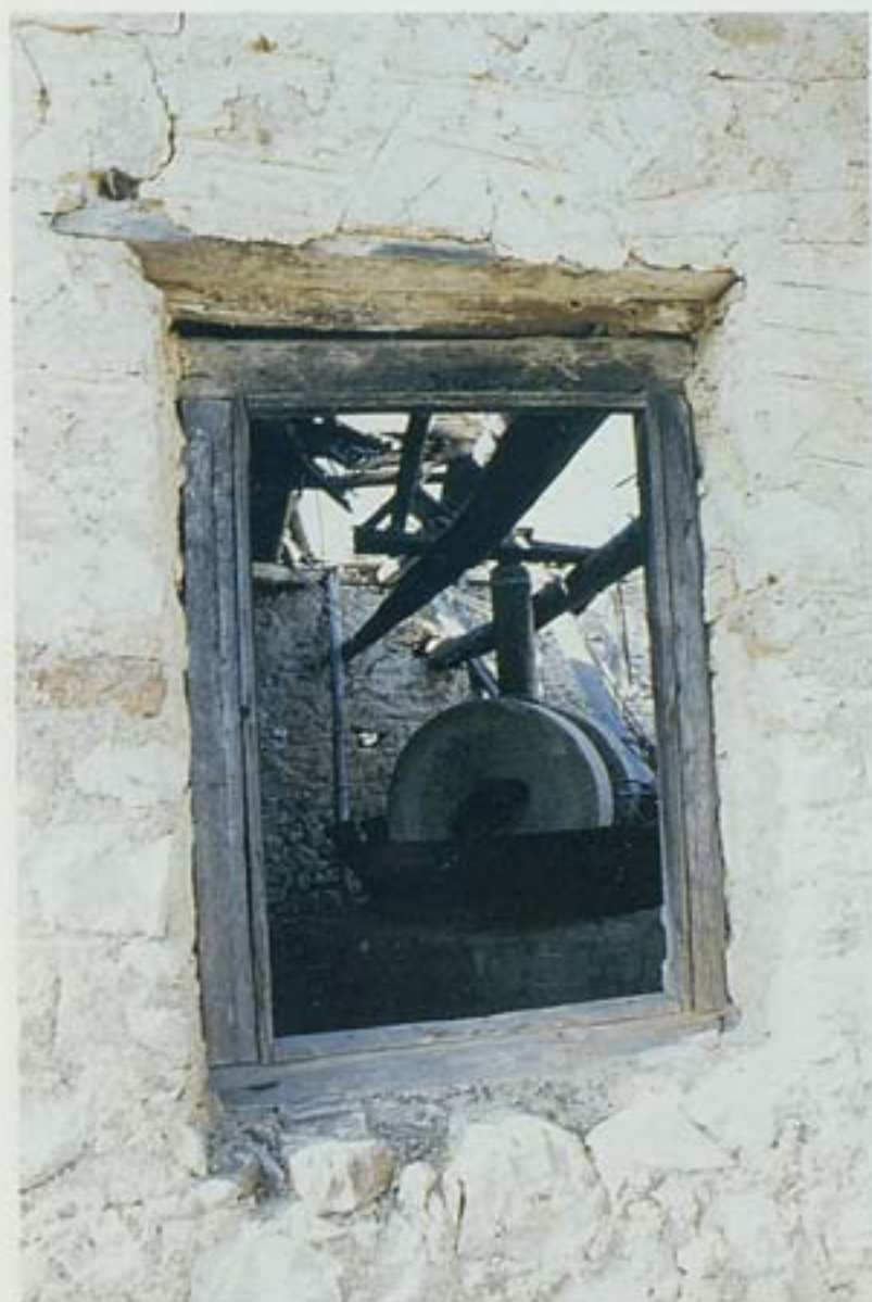
Εικ. 12. Παράθυρο από παλιό μηχανοκίνητο ελαιοτριβείο, απ' όπου διακρίνονται οι μύλόπετρες στο εσωτερικό του (Παπαφλέσσας Μεσσηνίας, 1998).
